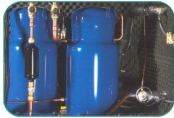
Scroll-Kompressoren Scroll compressors
